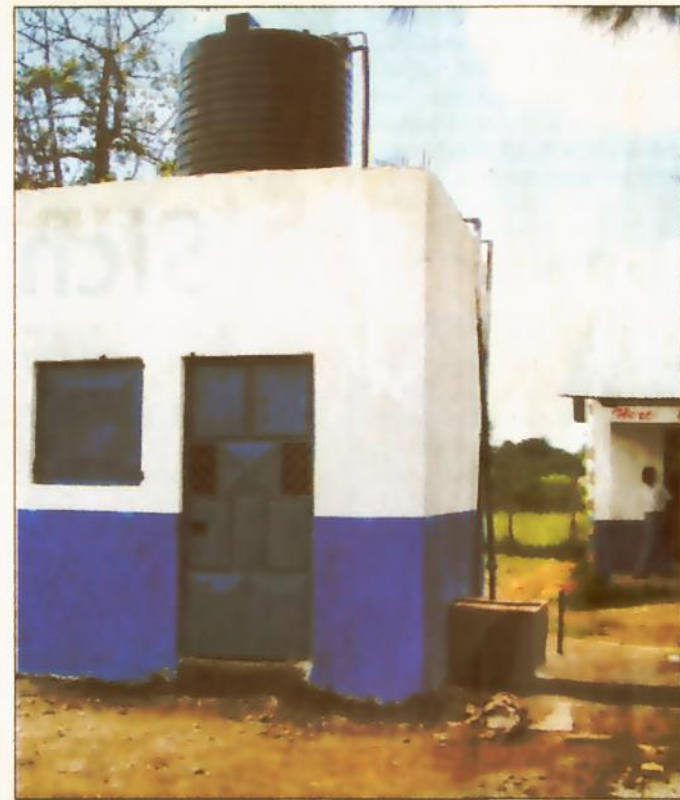
Finanziert durch Spender über den Verein „Wir helfen in Ukunda“: Für die Sanitäranlagen wurde ein Brunnen angezapft. Aus ihm wird das Wasser für die neuen Toiletten bezogen, wenn der sonst vom Regenwasser gespeiste Tank (oben) in der Trockenzeit leer ist. ■ Foto: pr
